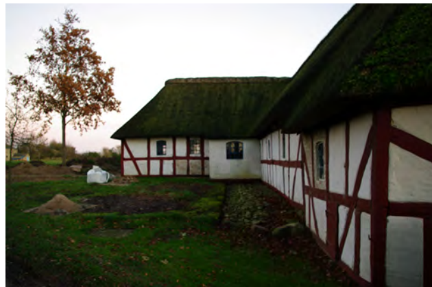
Gammelgård I Kalvehave er under restaurering og kan bruges til lokale formål.
